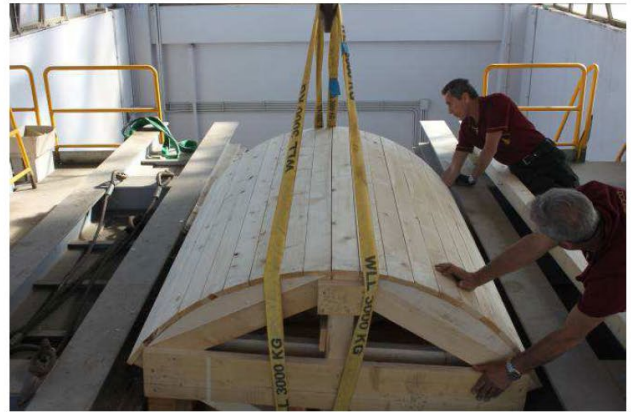
12/5/2015 – figura 25 Calo della centina nella bocca del forno orizzontale
