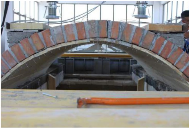
10/6/2015 – figura 48 Rimozione della centina
