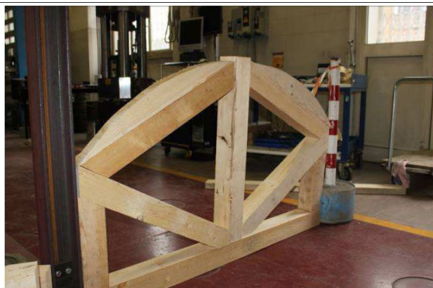
29/4/2015 – figura 12 Completamento della parte sommitale della prima centina
