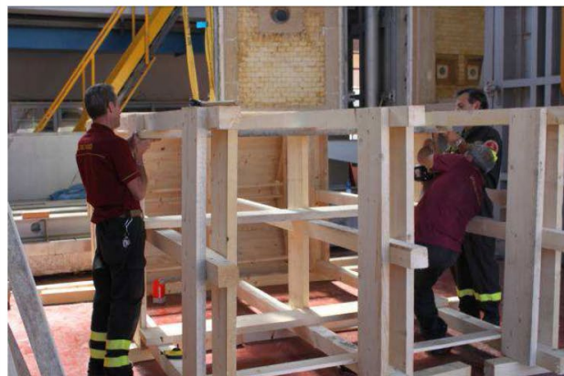
11/5/2015 – figura 19 Fasi di realizzazione piedritti cedrina
