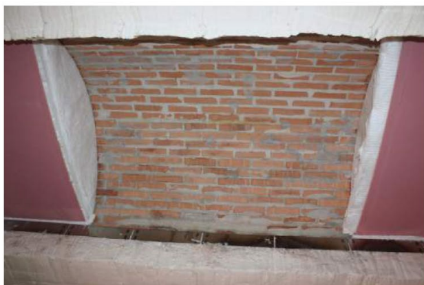
23/6/2015 – figura 58 Completamento della tamponatura del forno orizzontale
