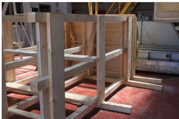
11/5/2015 – figura 20 Completamento realizzazione piedritti cedrina
