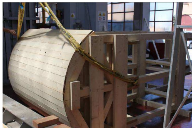
11/5/2015 – figura 21 Imbragatura della cedrina e collegamento al carroponete
