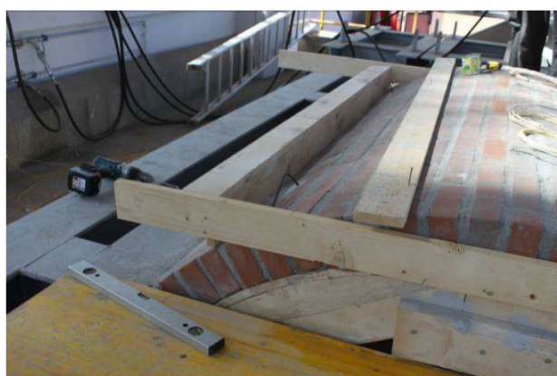
19/5/2015 – figura 39 Predisposizione di spallette in legno per getto cordolo di ripartizione del carico (vista degli spinotti di ancoraggio Ø8)
