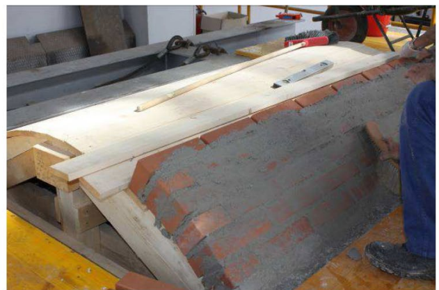
14/5/2015 – figura 29 Prosecuzione della realizzazione della volta muraria
