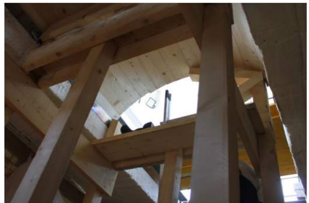
10/6/2015 – figura 47 Inizio rimozione della centina
