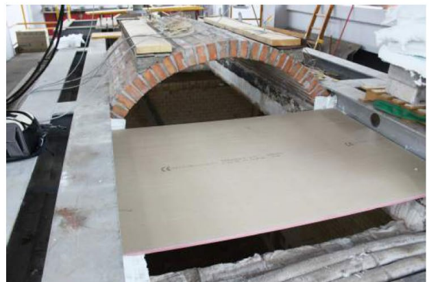
15/6/2015 – figura 53 Inizio tamponatura del forno
