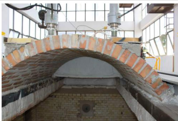
16/6/2015 – figura 56 Tamponatura frontale della volta con lana di roccia e cartongesso (vista interna)
