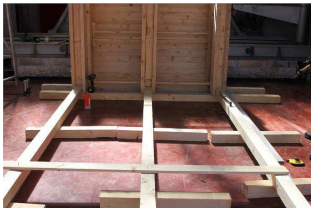
11/5/2015 – figura 18 Inizio realizzazione piedritti cedrina
