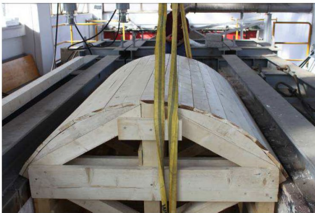
12/5/2015 – figura 26 Posizionamento definitivo della centina nella bocca del forno orizzontale
