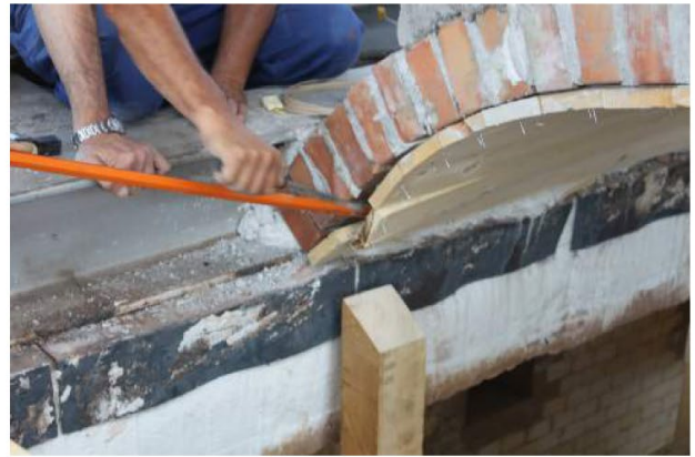
10/6/2015 – figura 49 Rimozione del tavolato
