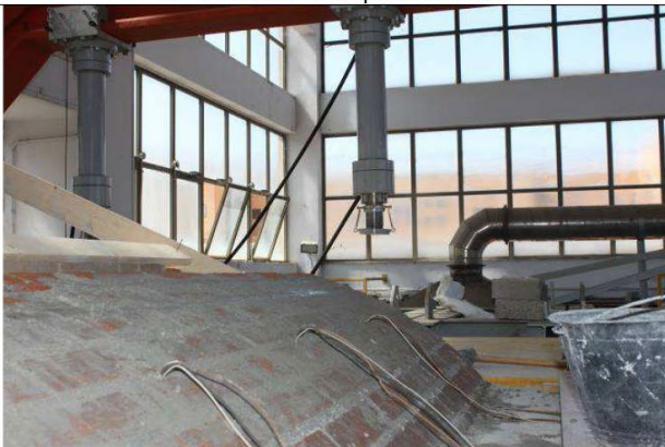
18/5/2015 – figura 34 Vista delle termocoppie interne in corrispondenza della sezione di applicazione del carico
