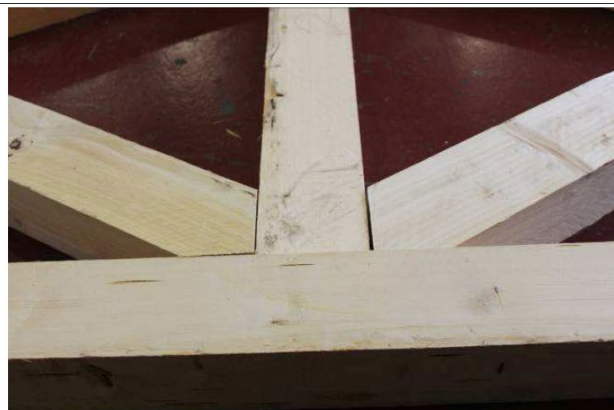
29/4/2015 – figura 13 Particolare del nodo inferiore
