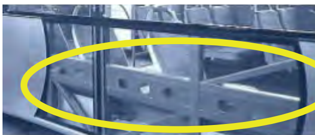
particolare del rinforzo laterale
