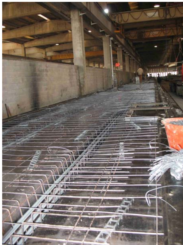
Figura 6.5 - Pista di precompressione per la realizzazione di tegoli, si noti l'armatura lenta
