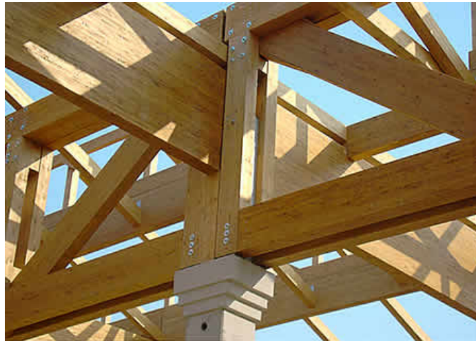
Figura 2.7 Travi in legno lamellare
