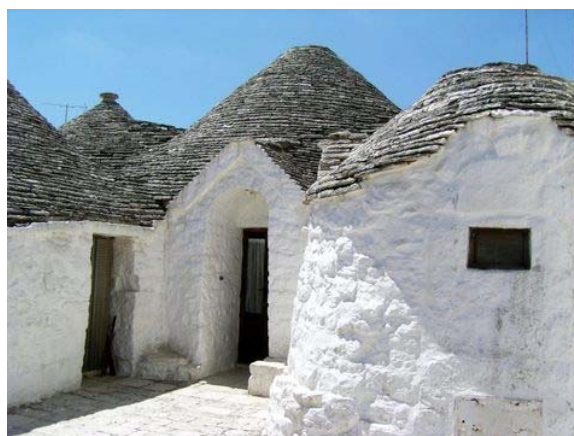
Figura 2.10 I trulli, esempio di costruzione in pietra
