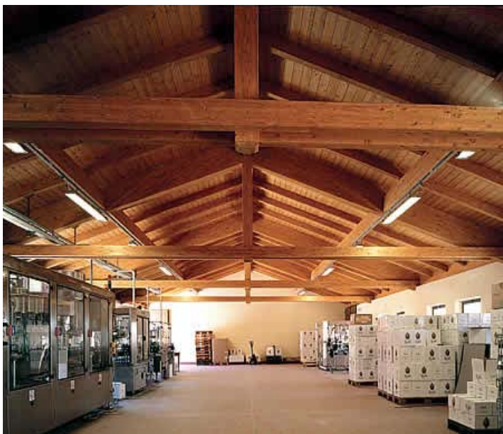
Figura 2.1 Esempio di capriata in legno
