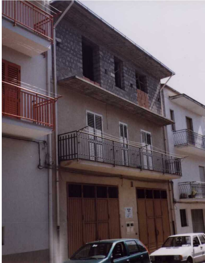
Figura 7.2 - Esempio di fabbricato sopraelevato
