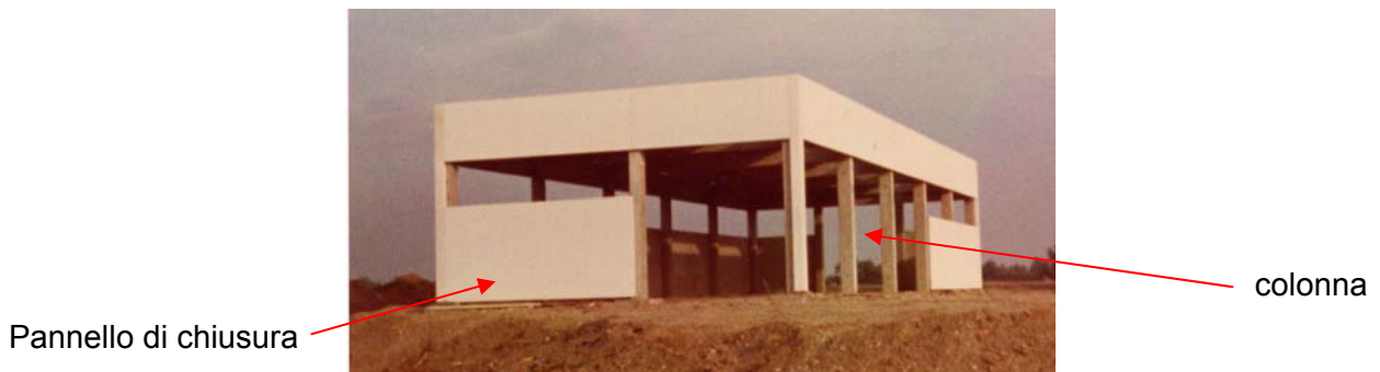
Figura 8.4 – Edificio prefabbricato in c.a.: vista esterna
