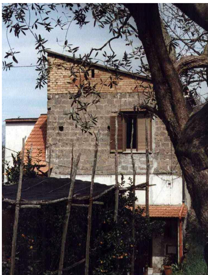
Figura 7.1 - Esempio di fabbricato sopraelevato
