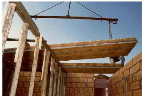
Figura 10.14 – Varo di solaio a pannelli prefabbricati
