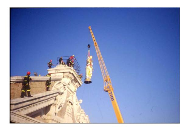
In particolare ogni operatore indossava un caschetto di protezione, un'imbracatura completa, un dissipatore di energia in caso di caduta (Fig. 1) [1], un discensore-assicuratore non bloccante (Fig. 2) [1], oltre all'equipaggiamento ordinario dei Vigili del Fuoco costituito dall'uniforme DPI e da stivali antinfortunistici.
