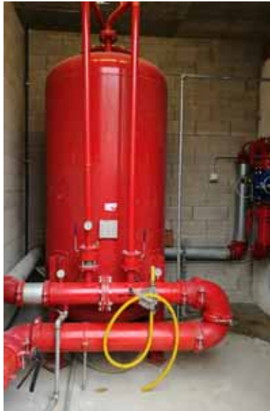
SERBATOIO DI SCHIUMOGENO E PREMISCELATORE
