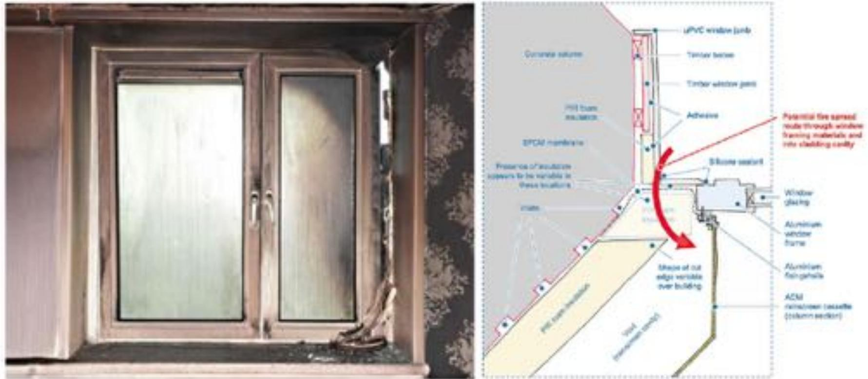
Figura 2.89 – Grenfell Tower: foto di una delle finestre meno danneggiate e disegno in cui è indicato (freccia in rosso) il percorso compiuto dal fuoco (fonte: prof. Luke Bisby, Phase 1 – Final Expert Report, fig.17, pag. 44
