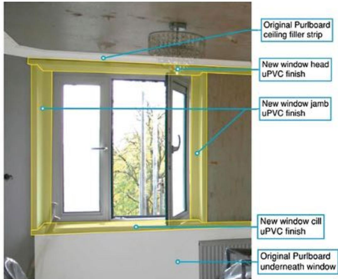
Figura 2.88 – Grenfell Tower: foto nuova finestra con stipiti, soglie e ciellini in PVC
