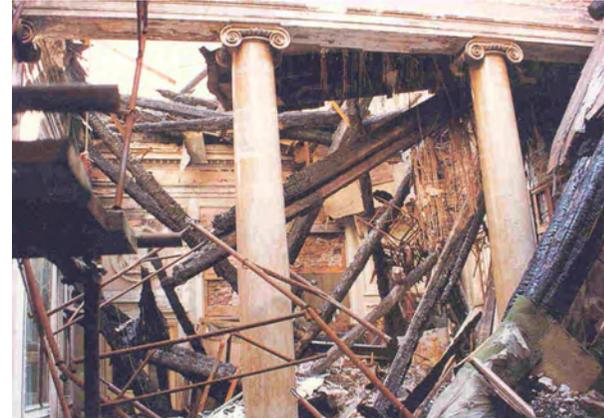
Partecipa alla combustione ma si consuma in modo lento ed uniforme (0,64 mm/min travi, 0,84 mm/min pilastri)
