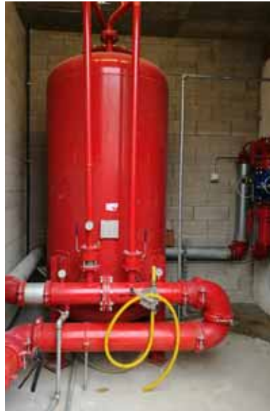
SERBATOIO DI SCHIUMOGENO E PREMISCELATORE
