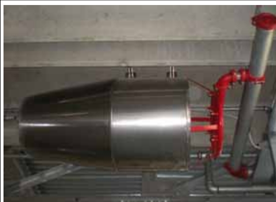
GENERATORE DI SCHIUMA AD ALTA ESPANSIONE
