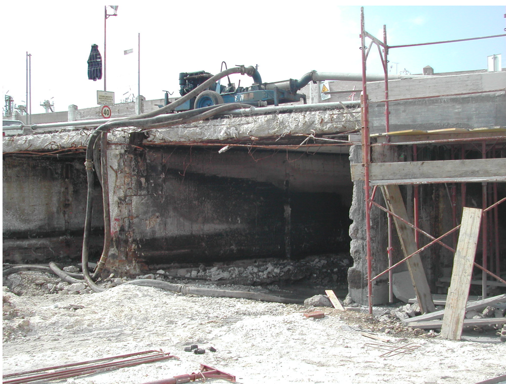
Foto n. 9 – Lavori di ristrutturazione dei cunicoli del sottopasso
