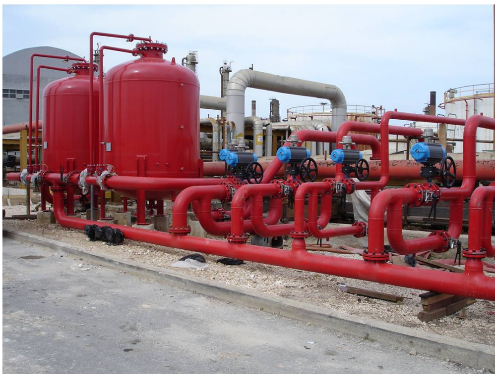
Foto n. 14 – Particolare delle centraline schiumogeno e delle connessioni con il nuovo impianto antincendio a protezione del sottopasso
