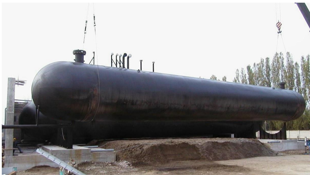
Fotografia n° 1 – Momento posa serbatoio D06
