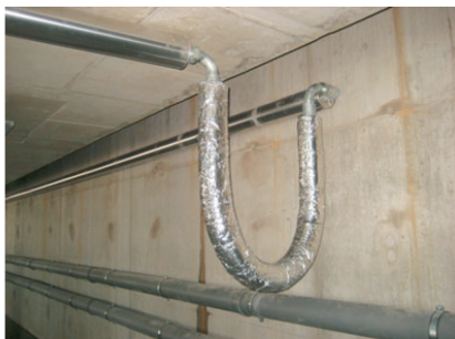
Figura 13 – Curva in una conduttura
