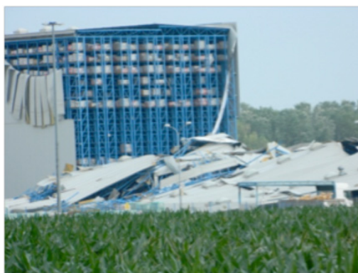
Figure 11, 12. Instabilità delle scaffalature in magazzini intensivi
