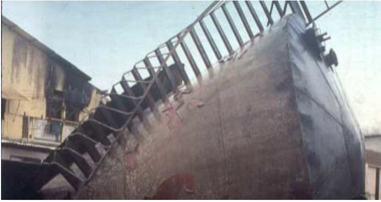
Figura 8 – Ribaltamento di un serbatoio
