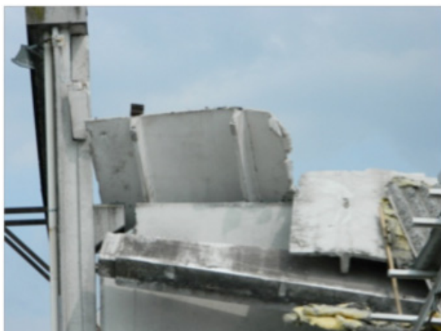
Figure 8, 9 – Caduta laterale della trave
