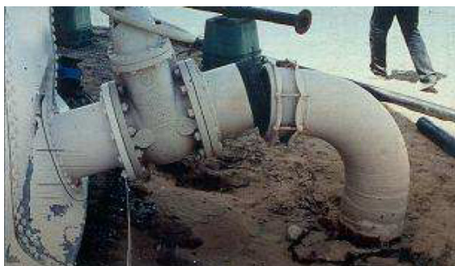
Figura 4 – Rottura tubazione
