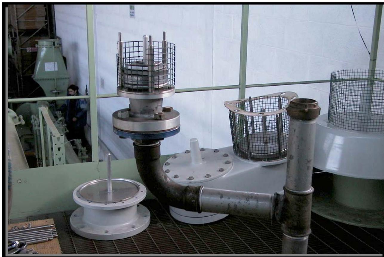
Foto 2- Torretta di ciclo chiuso con sfiato terminale dotato di valvola a pressione
