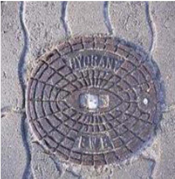
d) Nel caso in cui la saracinesca dell'idrante non si trovi all'interno dell'idrante in sottosuolo, essa si troverà nelle vicinanze al di sotto di un ulteriore chiusino metallico. Aprendolo utilizzando lo stesso metodo di quello precedente, si potrà accedere alla saracinesca della condotta utilizzando la chiave a " T " .
