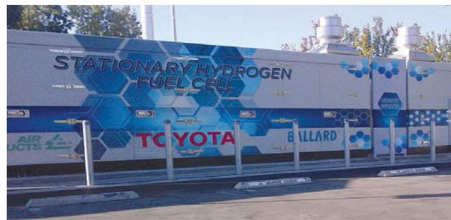
FC per sistema di cogenerazione di calore ed energia (CHP)
