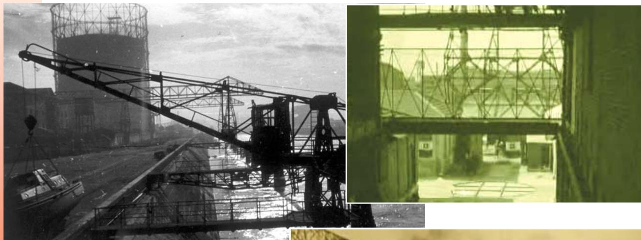
Le opere metalliche si spingono fino al Tevere, dove dalle imbarcazioni si caricavano i viveri da smistare nei magazzini all'interno dei fabbricati, tramite carri ponte ed argani di sollevamento.
