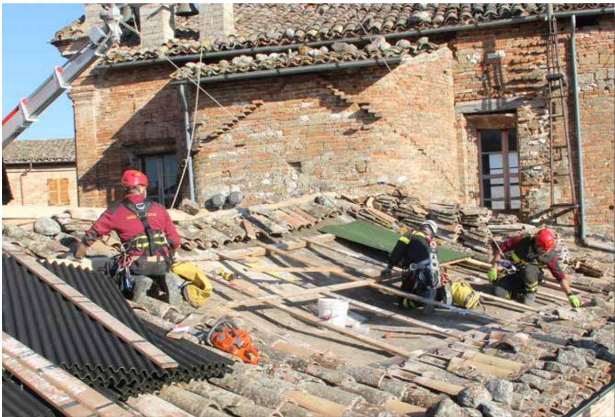
*Copertura tetto con lastre bituminose*
