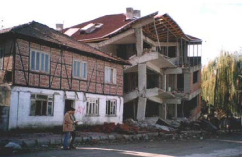
Esempio di casa baraccata che resiste al sisma, al contrario di una casa in cemento armato fortemente danneggiata
