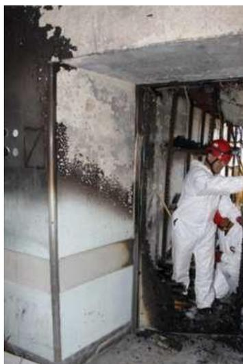
Nella prima foto in alto vediamo il distacco e il crollo di un'ampia porzione di intonaco e pignatte, che indica il punto dove c'è stata maggiore concentrazione di energia termica. Nell'altra foto vediamo invece un'altra "linea di demarcazione" che indica il punto di provenienza di calore e fiamme. Sopra la linea di demarcazione è ben visibile un *clean burn*, ossia un segno di "combustione pulita".
