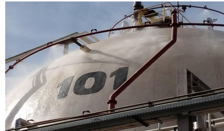
Attività di raffreddamento del LOC 1 (sfera GPL 101) sistema di protezione attiva
