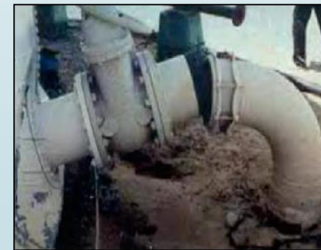
rottura delle tubazioni
