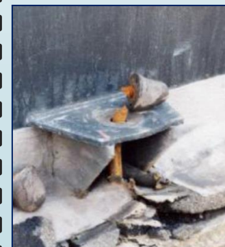
rottura degli ancoraggi
